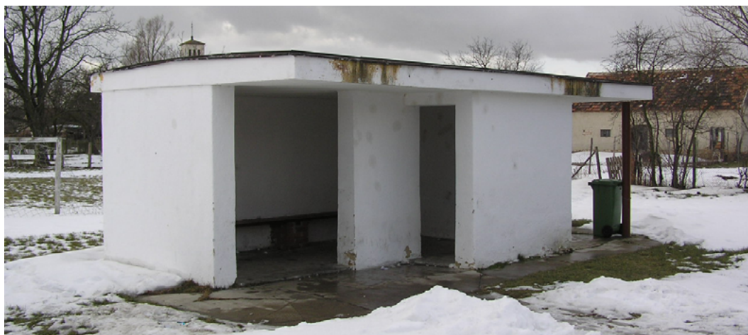
6. ábra: Csáfordjánosfa (Győr-Moson-Sopron megye). Összetett alaprajzú, fedett-nyitott térszerkezetű buszváró. A változatos alaprajzi elrendezésnek köszönhetően mindig van szélvédett hely az épületben
