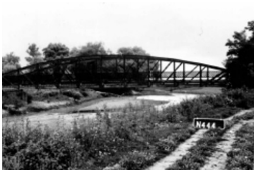
11. ábra. A Pósténypusztai híd elbontása előtt.
