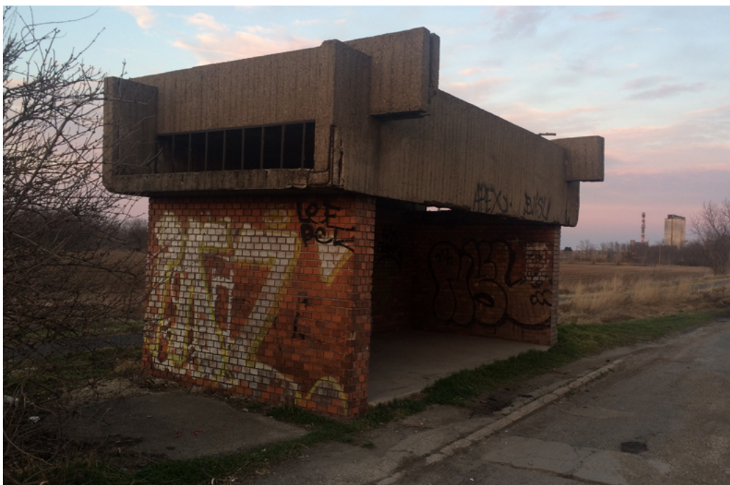
3. ábra: Almásfüzitő (Komárom-Esztergom megye). A főút mellett elhelyezkedő, nyerstégla-látszóbeton felületekkel kialakított buszváró épület a fentről érkező fény következtében izgalmas térélményt nyújt, az épület magas építészeti minőséget képvisel
