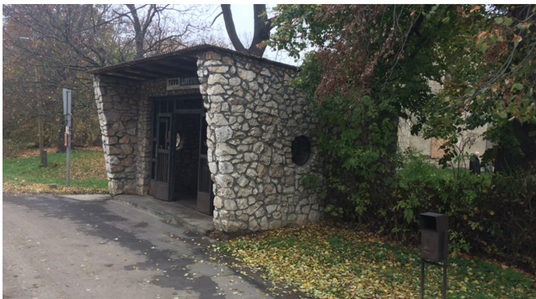
5. ábra: Egyed (Győr-Moson-Sopron megye). Kőburkolat, kifelé dőlő pofafal, kerek ablak, korszerű lakatos szerkezetű üvegfal: a modern építészet jellegzetességei a buszváró épületén
